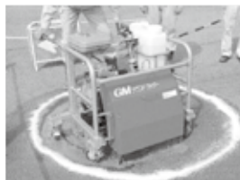
2 切断作業 GMラウンドカッターを設置し、5cm毎に最大深さ15cmまで切断します。
