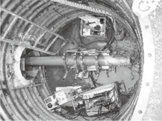
市街地や道路横断など開削工法が困難な場所において、既設管に新管を挿入して管路を構築するパイプインパイプ工法です。
