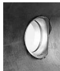
SUSブッシュ取付状況 (管内面)
