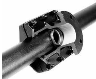
SUSブッシュ取付状況 (管外面)
