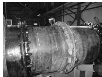
写真：呼び径900 水圧0.75MPa異常なし
