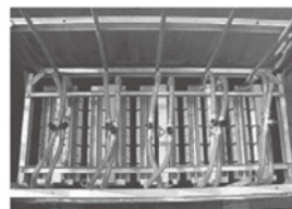
膜分離活性汚泥法
