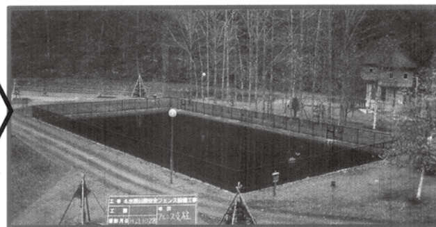
格子フェンス設置
