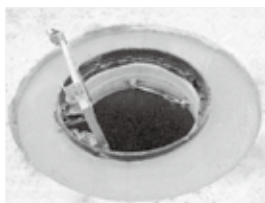
5 路盤材充填作業 ラウンドベースを用いて路盤部を充填します。
