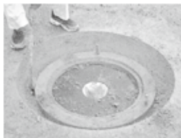
3 土砂除去作業 切断完了後、ブローカー等を用いてマンホール周辺の土砂を除去します。
