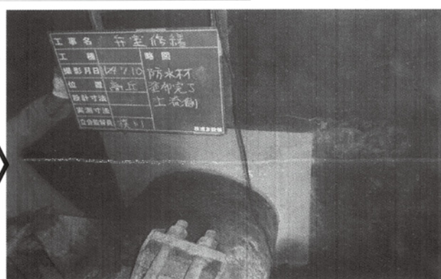
弁室内漏水補修
