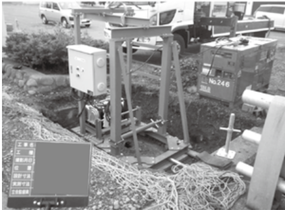
引込用ウインチ設置
