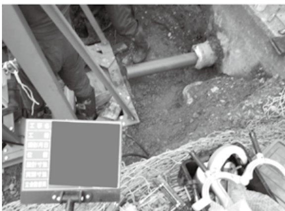
既設水道管への挿入完了
