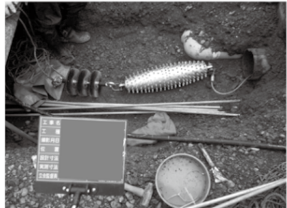
既設管の簡易クリーニング
