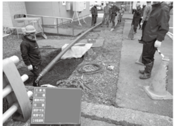
既設水道管への挿入
