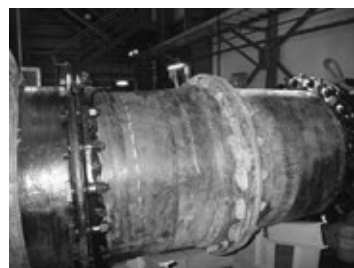
写真：呼び径900 水圧0.75MPa異常なし
