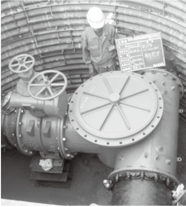
札幌市水道局 \phi 700 \times \phi 700 HC工法
