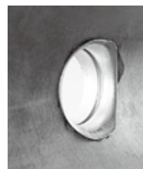
SUSブッシュ取付状況 (管内面)
