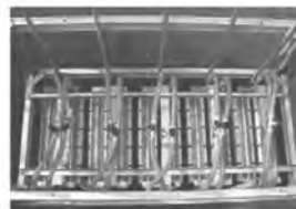
膜分離活性汚泥法
