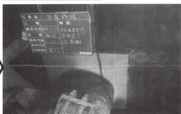
弁室内漏水補修
