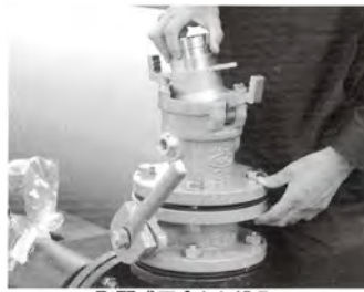
町野式口金ねじ込み、 排水弁取り付け
