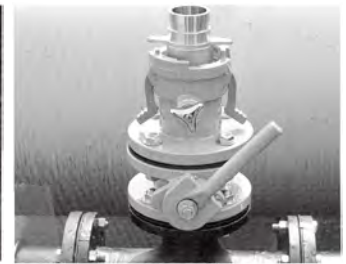
カムロック後、 町野式口金取り付け完了
